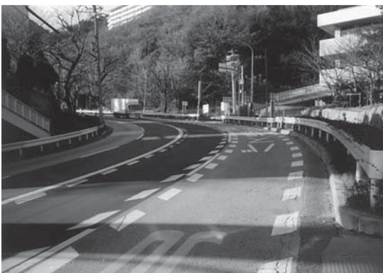
工事前 事故多発地点
