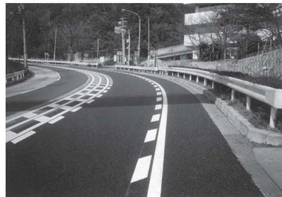
完成後 事故多発地点
