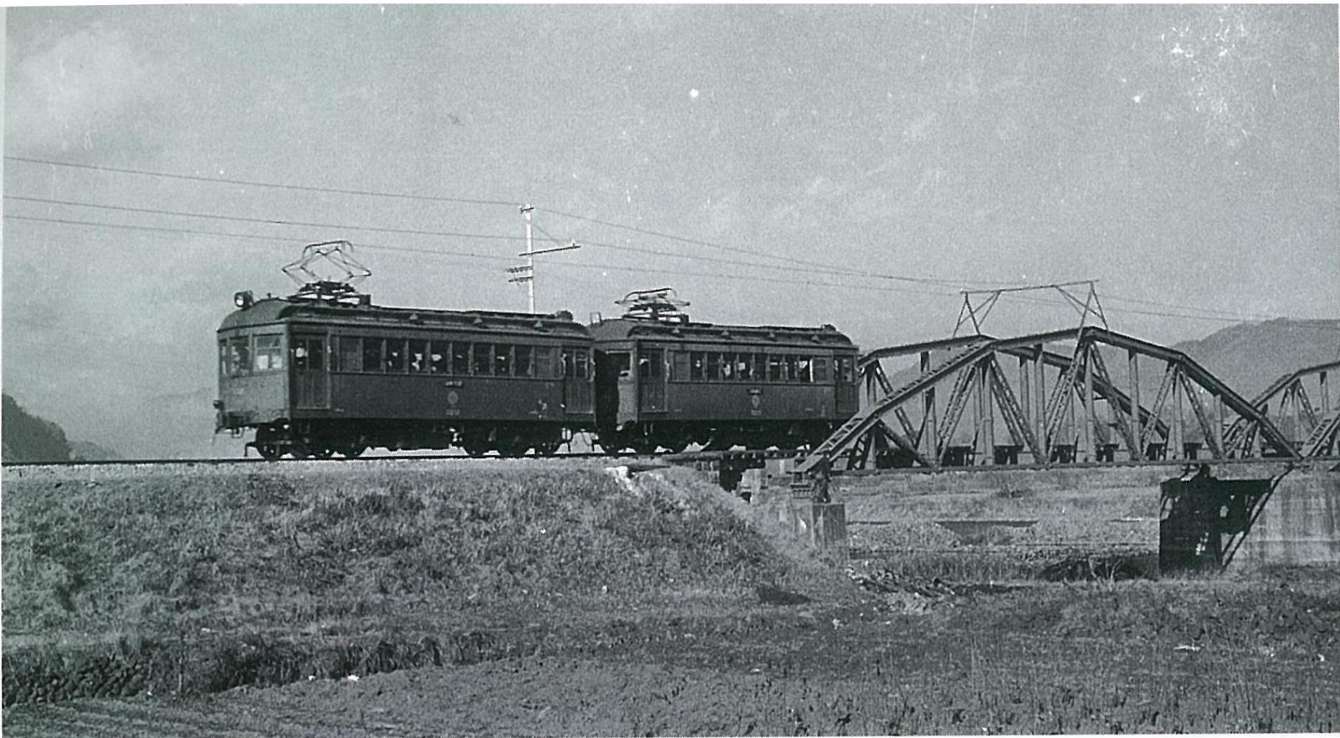
千曲川を渡って丸子町に向かうモハ3214+モハ3213。右に見える大屋鉄橋の丸子側2連は丸子鉄道開業時はプレートガーダーであったが、昭和3年8月に水害で流失、代替に曲弦ワーレントラスが遠く九州から運ばれ、掛け替えられたものであった。 1956.3 大屋-信濃石井 P:長谷川 明
