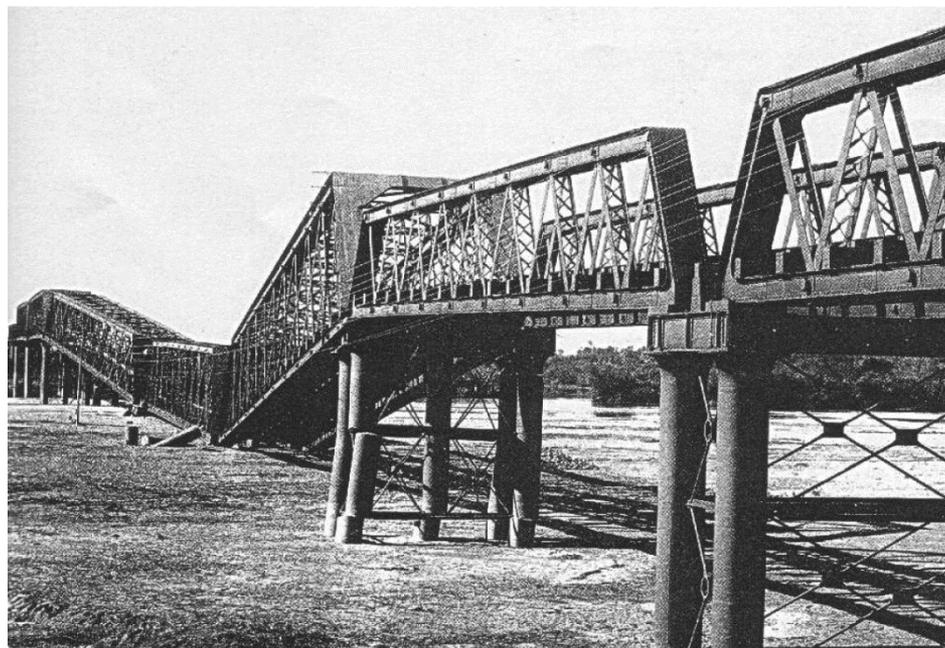
橋台: 径1m $\phi$  厚さ3cmの鑄鉄管 $\times$ 2本
