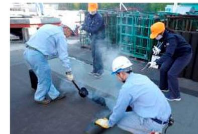
写真4 作業員2(まき手・左側)と作業員3(押し手・右側)の作業環境測定の様子 作業員2は一斗缶に入れた溶融アスファルトをひしゃくで施工場所にまいている。作業員3は、巻いたルーフィングシートを作業員2がまいた溶融アスファルトの上に広げて貼付している。
